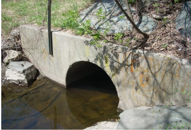
Photo: CSO 054 Project Overview
