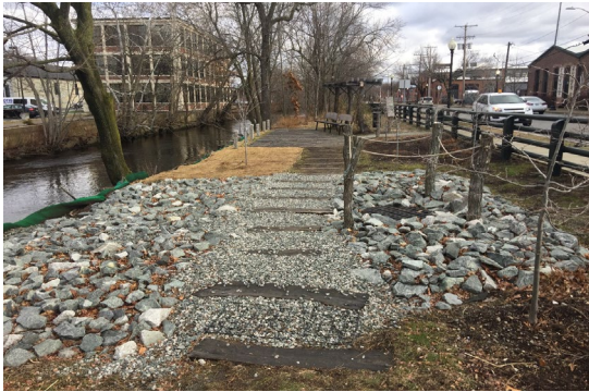
Photo: Site of Woonasquatucket CSO Interceptor
