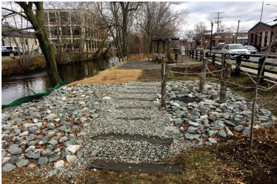
Photo: Site of Woonasquatucket CSO Interceptor
