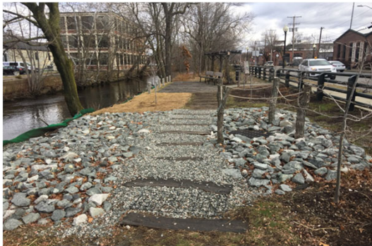
Photo: Site of Woonasquatucket CSO Interceptor
