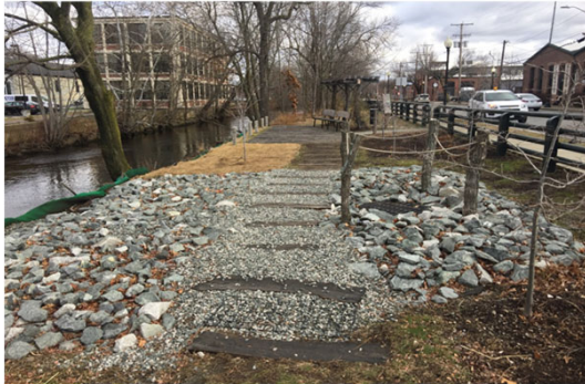
Photo: Site of Woonasquatucket CSO Interceptor
