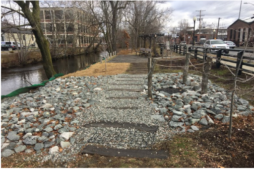
Photo: Site of Woonasquatucket CSO Interceptor
