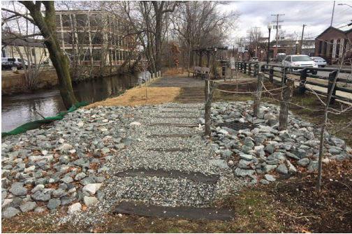
Photo: Site of Woonasquatucket CSO Interceptor
